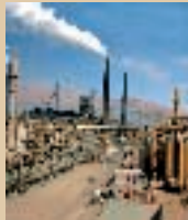
FOTO CARATULA Fundición Modernizada de Ilo y dos plantas de ácido sulfúrico
